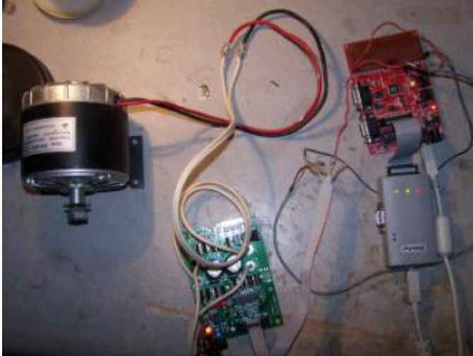
Fig. 14 Pruebas de funcionamiento del controlador de motores.
