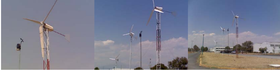
Fig. 17 Vistas del Aerogenerador Horizontal y pequeño parque eólico.
