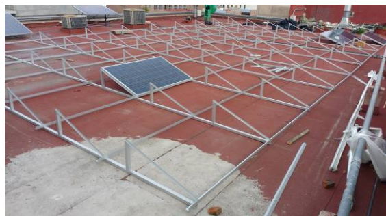
Figura 11 Vista de ensamble de la estructura de aluminio para el soporte de los paneles.
