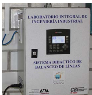
Figura 12 Vista de uno de los tableros construidos.
