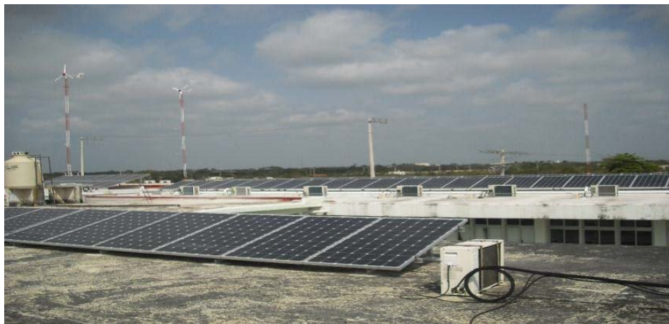
Figura 1 Sistema de generación fotovoltaico.
