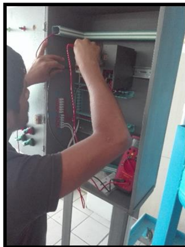
Figura 7 Prueba de lazo de control.
