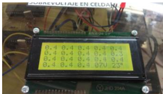
Figura 16 Sistema de monitoreo voltajes y temperatura, comunicación CAN banco de SCs.
